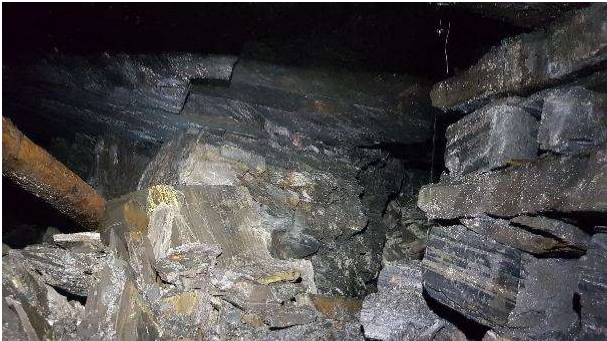
Zavalující odlučné plochy chodby B23 – nutné vyzmáhat a zajistit
